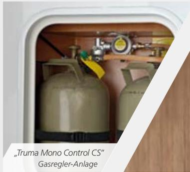
„Truma Mono Control CS“ Gasregler-Anlage
