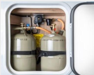
„Truma Mono Control CS“ Gasregler-Anlage
