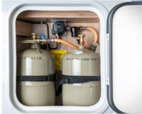
„TRUMA Mono Control CS“ Gasregler-Anlage
